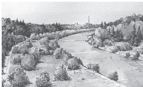
Izara przed renaturyzacją płynęła skanalizowanym korytem z progami dennymi oraz zabudowanymi brzegami.
