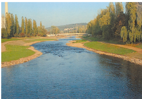
Enz po renaturyzacji. Zburzona powierzchnia wody wskazuje na bardziej zróżnicowane zachowanie prądu niż w stanie wyjściowym. Rzeka staje się lepiej natleniona.
