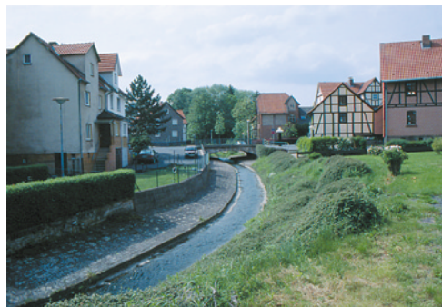
Pomimo prowadzonej renaturyzacji część potoku Bauna pozostała zabudowana technicznie.
