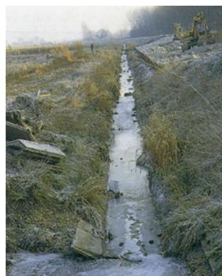
Renaturyzację rozpoczęto od usunięcia betonowych umocnień koryta.
