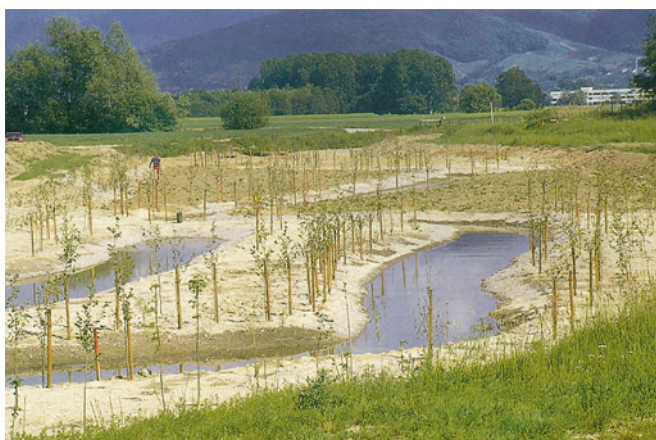
Po wykonaniu poszerzenia terasy zalewowej i koryta, na brzegach nasadzone pojedyncze olsze i wierzby. Takie ukształtowanie potoku umożliwiłoby przejmowanie większego czoła fali powodziowej i zachowanie krajobrazu otwartych łąk.
