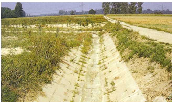
Przed renaturyzacją Kleines Sulzbächle był prostoliniową rynną, wyłożoną betonowymi płytami.
