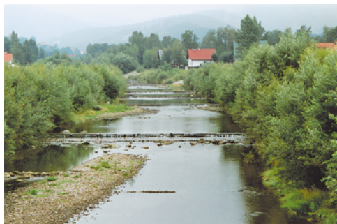
Zabudowa terenów zalewowych jest główną przyczyną powodzi. Zbliżające się do rzeki budownictwo zabiera należną jej przestrzeń.
