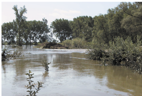
Straty spowodowane awarią obwałowań na terenach przez nie chronionych są wielokrotnie większe od strat obszarów nieobwałowanych.
